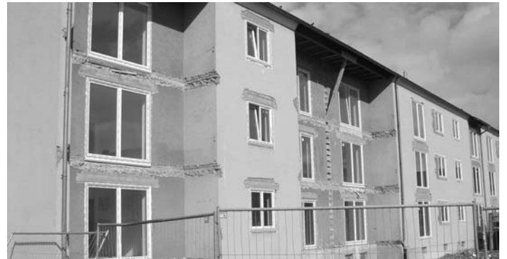
Sanierung der Karlsbader Str. 2 bis 4a
