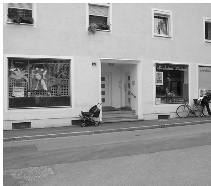
Hinter dem linken Schaufenster entsteht die Ladenerweiterung
