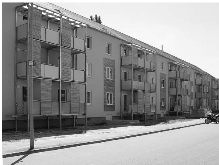
Gelungene Umbaumaßnahme in der Stettiner Str. 16 - 26
